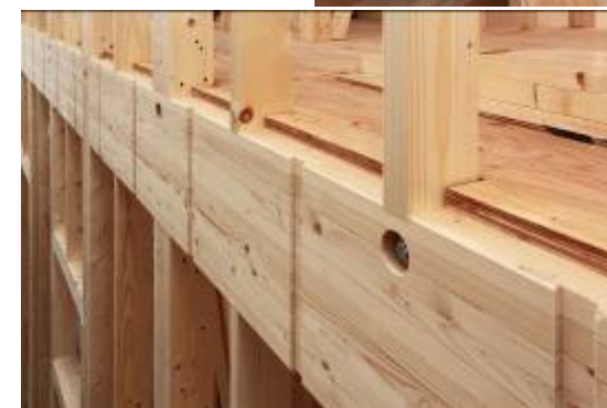
「SxL-Wood構法(換気付木造)」
