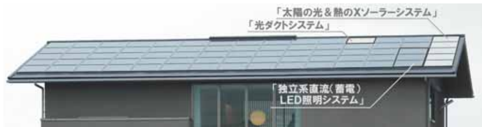
「独立系直流(蓄電)LED照明システム」 「光ダクトシステム」 「太陽の光&熱のXソーラーシステム」
