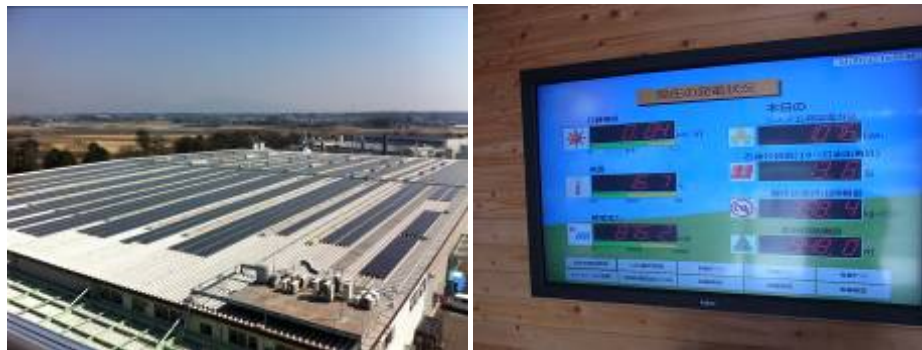
つくば工場 メガソーラー設置
